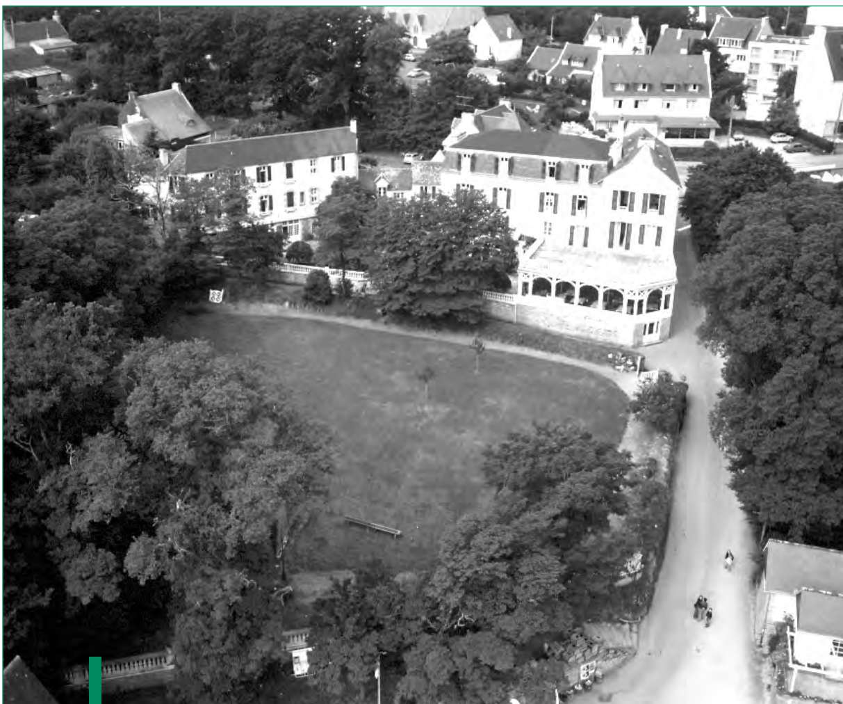
Le CEMPAMA à Fouesnant, dans le Finistère.
